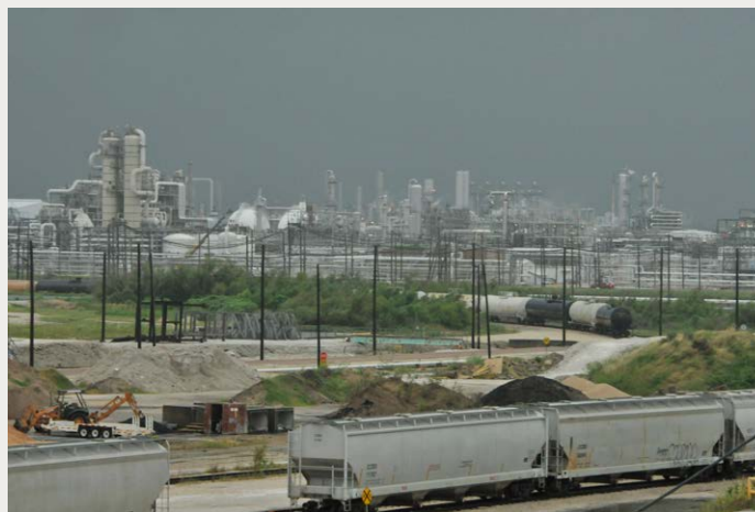
Durchgefallen! Greenpeace-Sicherheitsinspektion der texanischen Anlage von Dow Chemical (2010). © Bob Pearson, Greenpeace.
